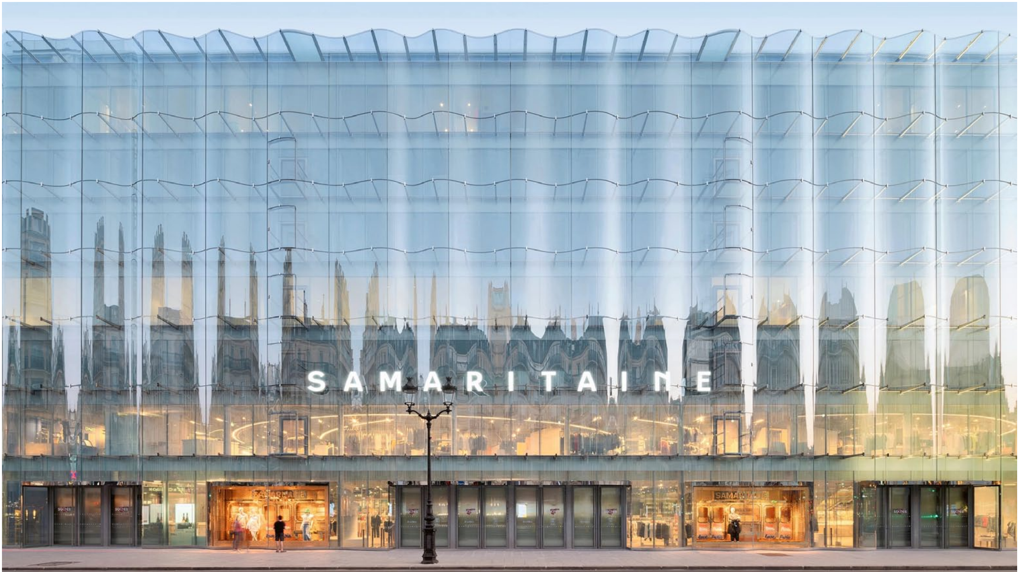
Der aktuelle Zustand des Samaritaine-Stammhauses: Die Glaswellen-Fassade der Rue Rivoli.
