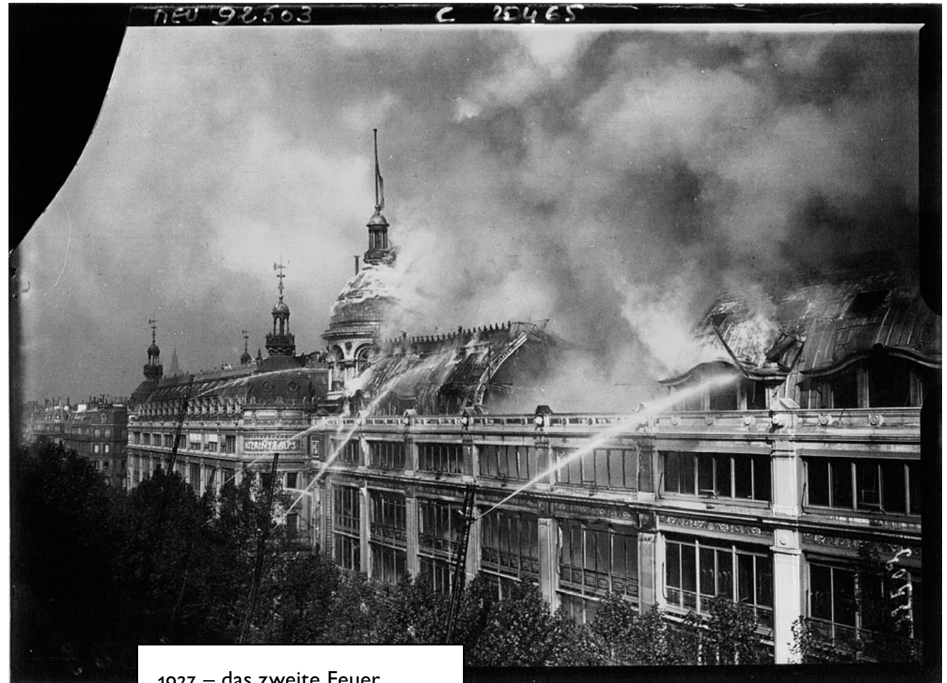
1923 – das zweite Feuer. Dannach wurde die Glaskuppel errichtet.
